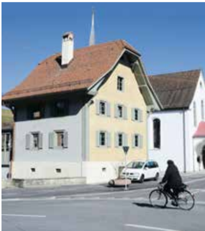
> 7: Das denkmalgeschützte Sigristenhaus wurde saniert. Foto Monika Wüest
